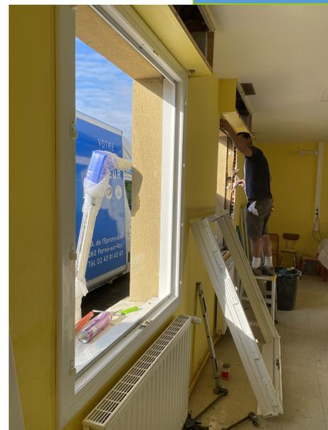
Après un audit énergétique, le conseil a fait le choix de changer les menuiseries, de refaire l'éclairage et la ventilation, le mode de chauffage (chaudière à granulés), l'ambiance acoustique des locaux ainsi que les peintures.
